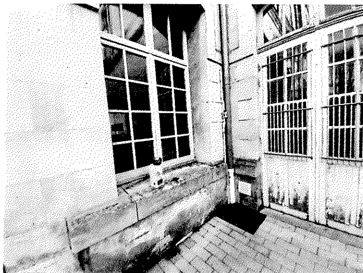
Figure 8. Réserve du Quai Carnot. Prélèvement d'air extérieur A15 dans la cour de l'ancienne bibliothèque.
